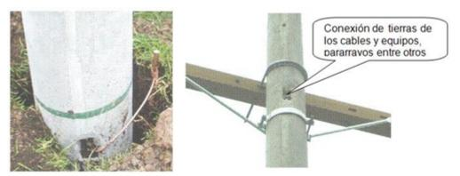
Figura No. 4. Conexiones inferior y superior al electrodo de Puesta a
