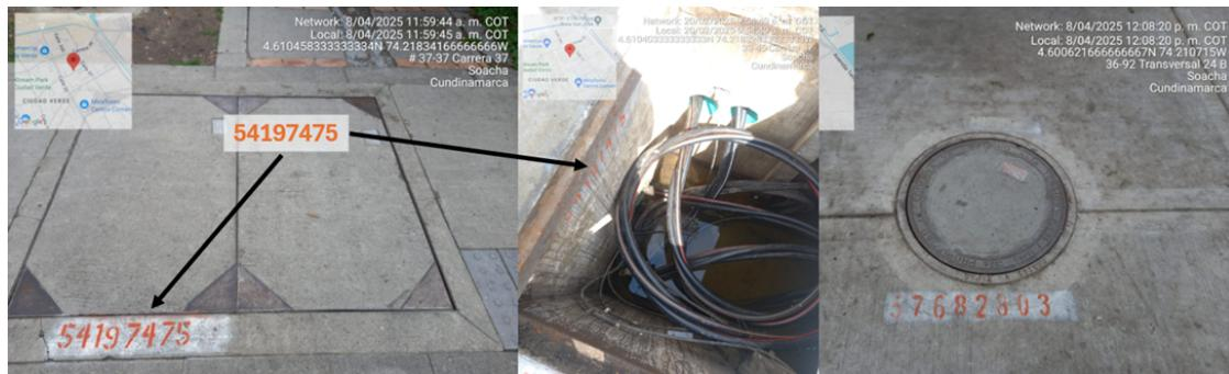
Adicionalmente al pintado del número se debe hacer la marcación del mismo código pintado en el interior de cada cámara subterránea, el tamaño de los números debe ser: largo 5 cm, ancho 3.0 cm y una separación de 1.5 cm, la pintura usada para la marcación debe cumplir con la especificación [técnica ET952](#)
