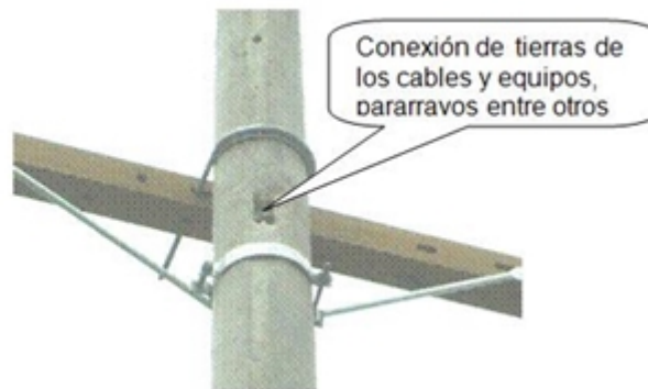
Figura No. 4. Conexiones inferior y superior al electrodo de Puesta a
