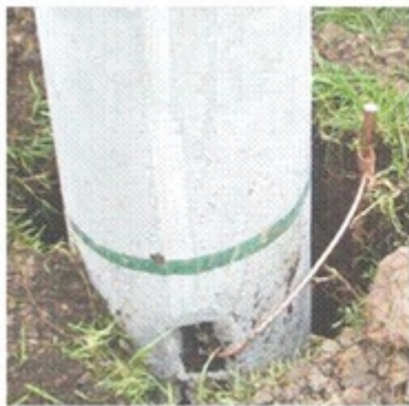
Figura No. 4. Conexiones inferior y superior al electrodo de Puesta a
