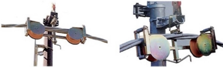
Figura 3. Poleas para estructuras de suspensión
